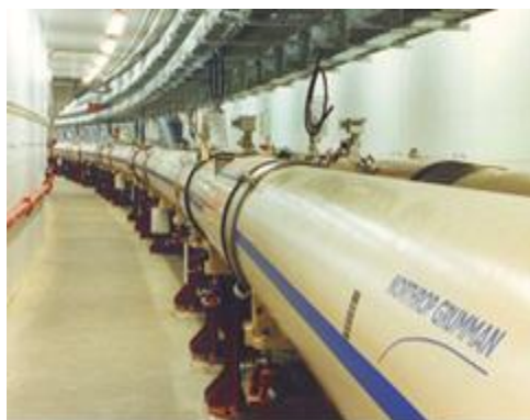
Εικόνα 3. Η σήραγγα του επιταχυντή RHIC στο Brookhaven
